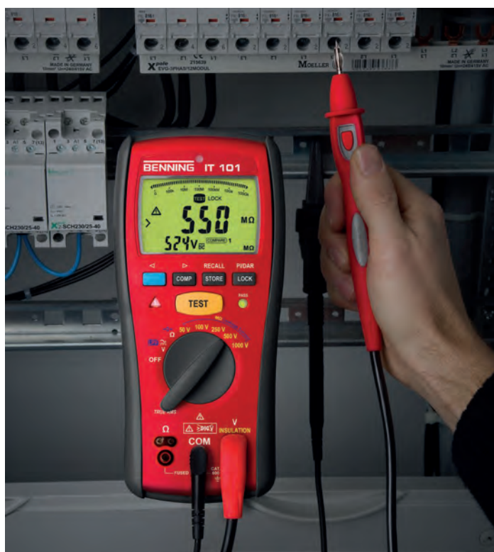
Isolationswiderstandsmessung einer elektrischen Anlage (BENNING IT 101 (044033))
